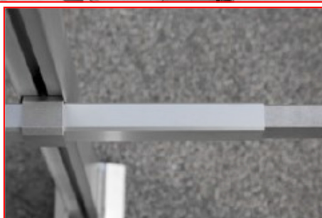
Corrimano regolabile in altezza in base all'andamento della copertura.
